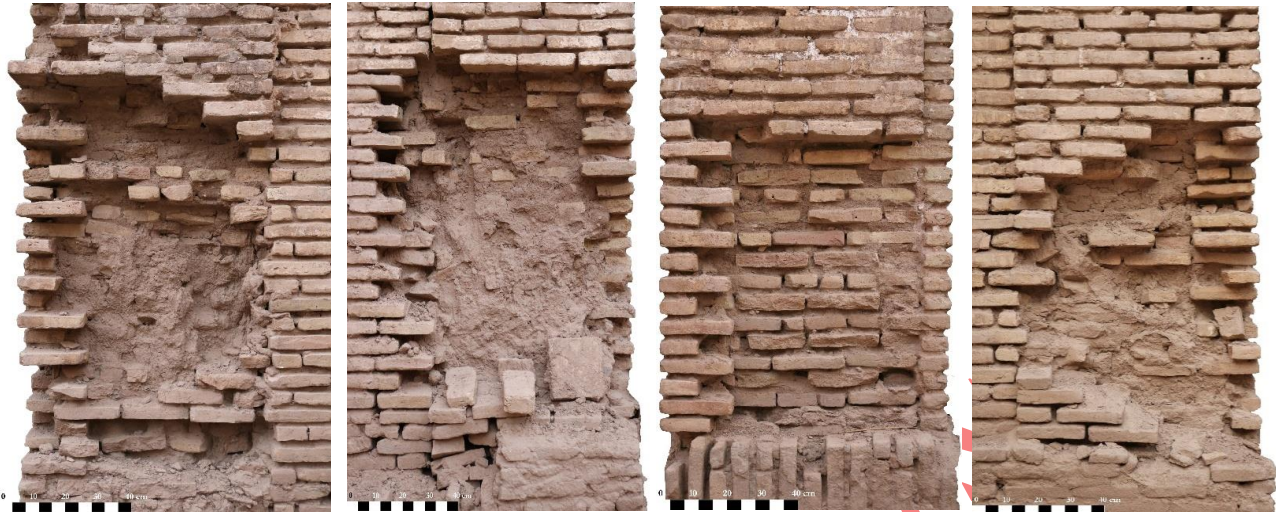
شکل ۱۳. ساختار آجری نما و هسته دیوارهای اطراف حیاط (منبع: نگارندگان)
