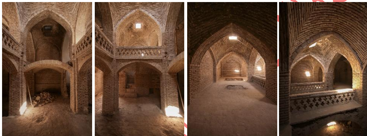
شکل ۱۶: تصویر داخلی فضای ۱۷. الحاق کمرپوش‌های میانی جهت احداث طبقه دوم (منبع: نگارندگان)
